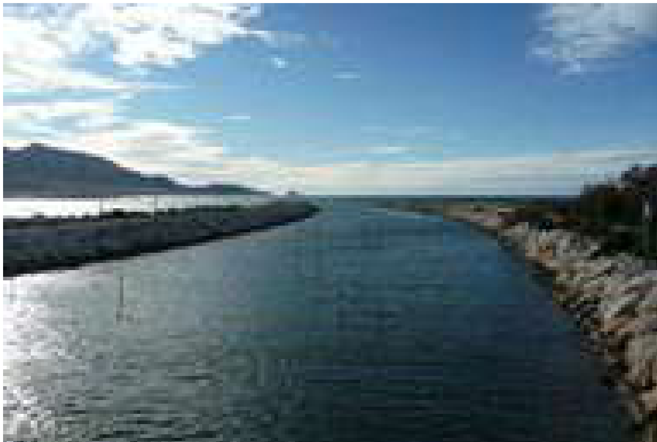
Figure 7 : L'exutoire naturel au Prado
