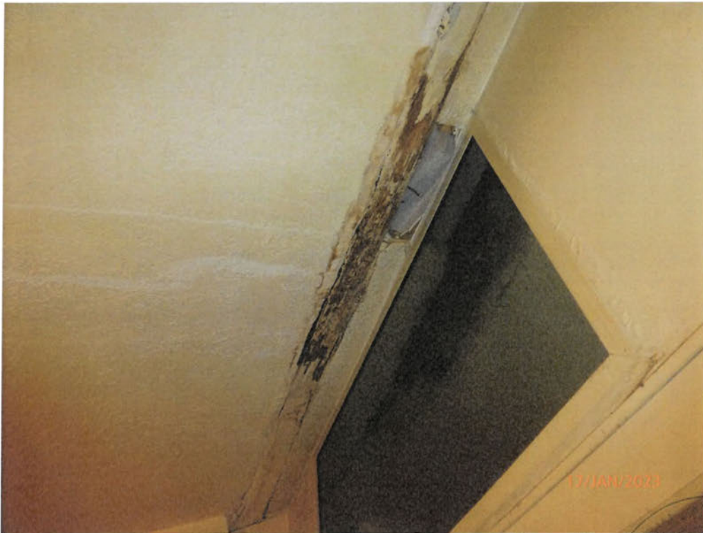
Photo 9 – Poutre au plafond d'aspect dégradé
