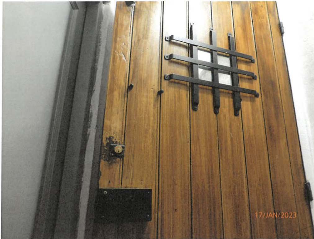
Photo 3 – Porte d'accès en bois
