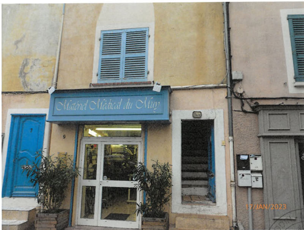
Photo 1 – Entrée de l'immeuble
